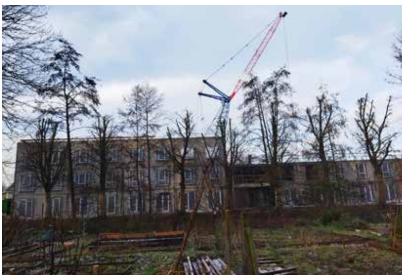
De huidige situatie, 3e laag casco in aanbouw.
